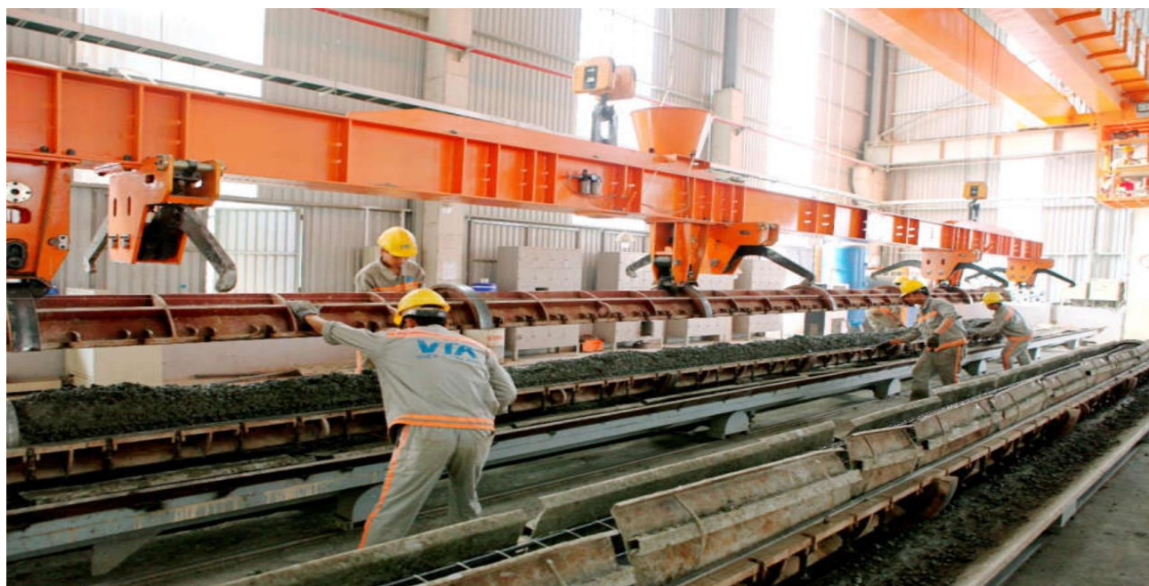
Hệ thống rải bê tông
